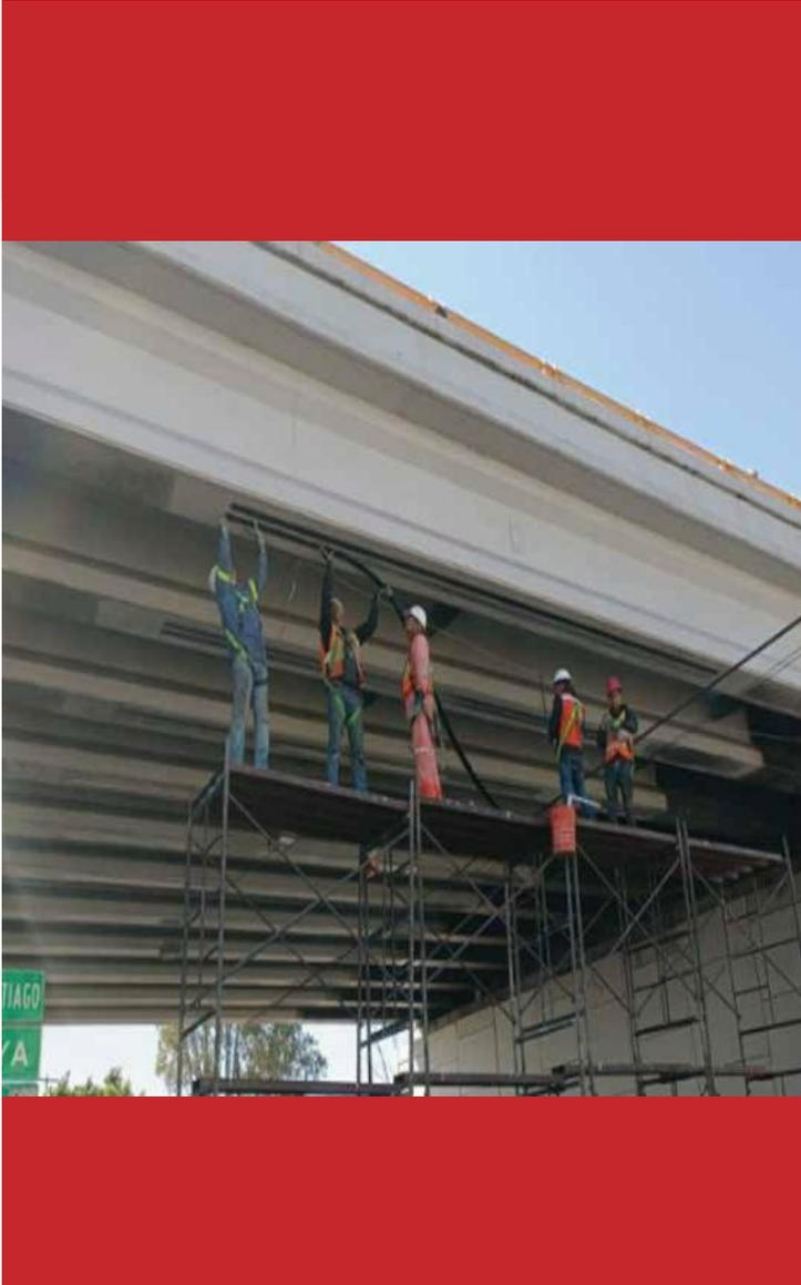
Rehabilitación de 11 estructuras, las cuales incluyen el servicio de reforzamiento por medio de fibra de carbono en tejido y platina, gateo de dichas estructuras para sustitución de apoyos de neopreno y suministro y sustitución de junta de calzada, en Irapuato, Guanajuato.
