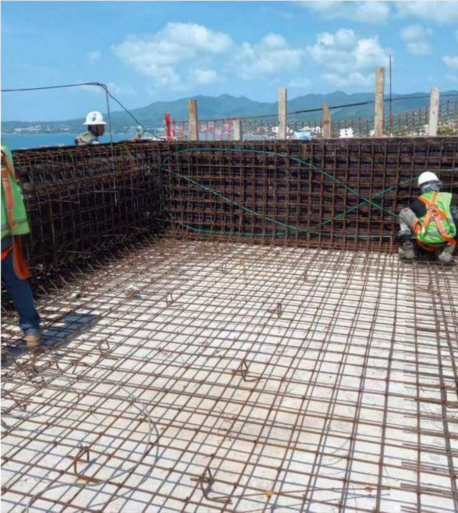
Servicio de postensado en muros y losa de alberca en altura con sistema autoprotegido T13, lo cual nos permite evitar filtraciones.
