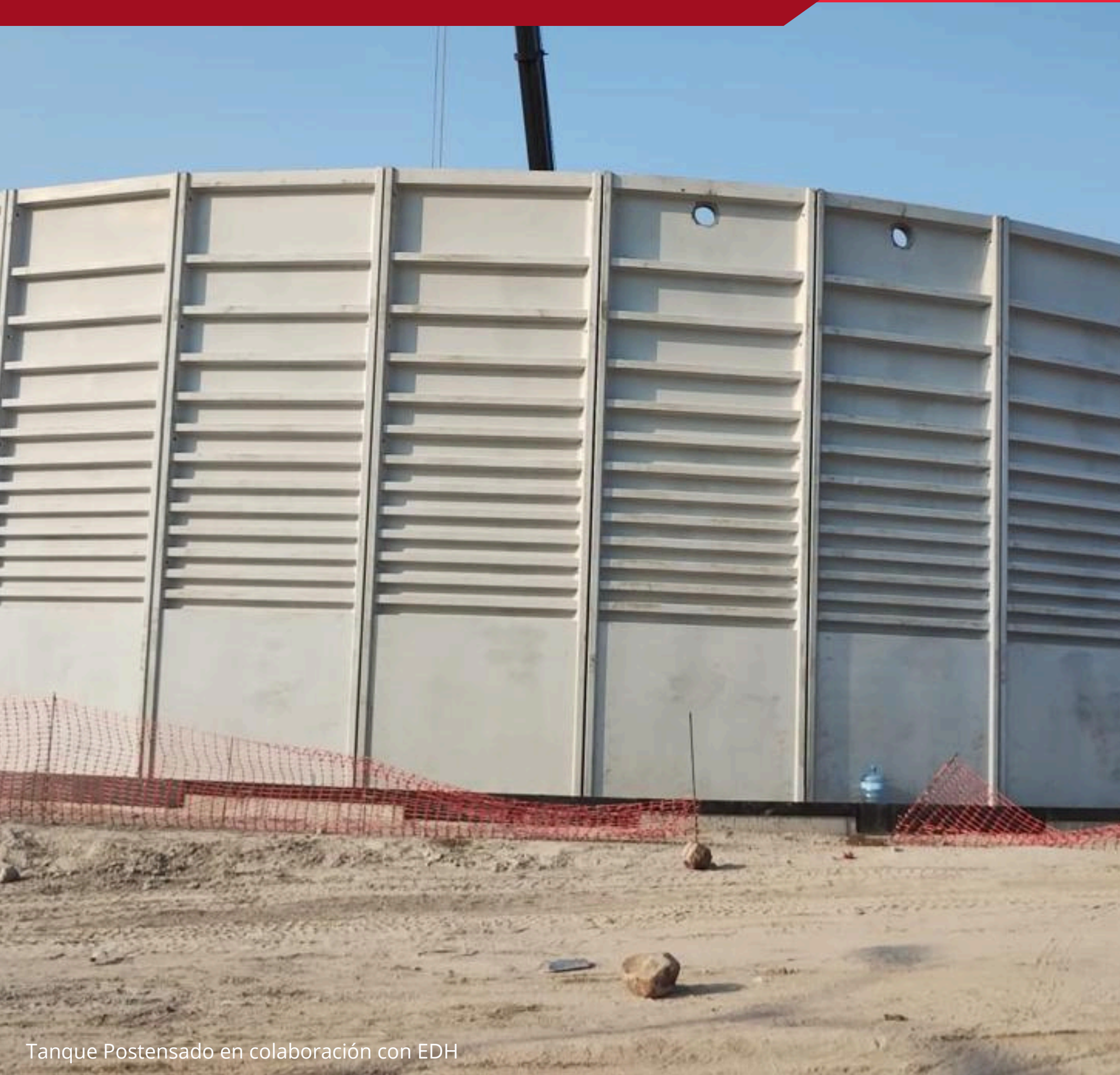
Tanque Postensado en colaboración con EDH
